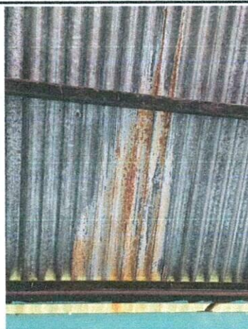
Foto 4: El techo de una de las aulas se encuentra dañado por la oxidación lo que provoca que durante las lluvias el agua ingrese al interior del aula.
