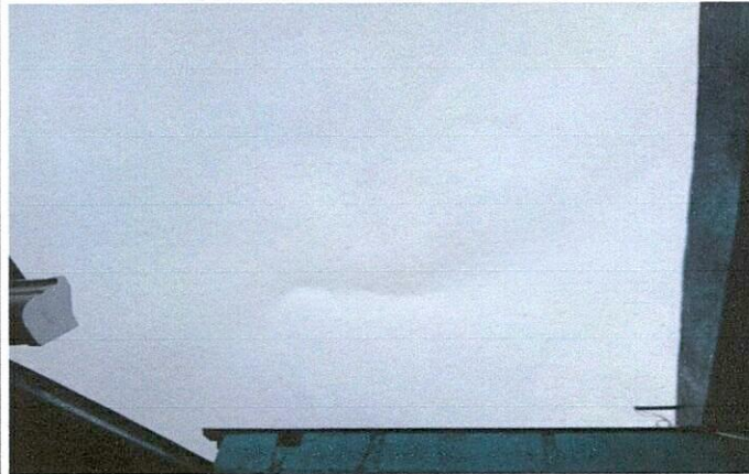
Foto 2: Entechado del área de lavamanos y trapeadores
